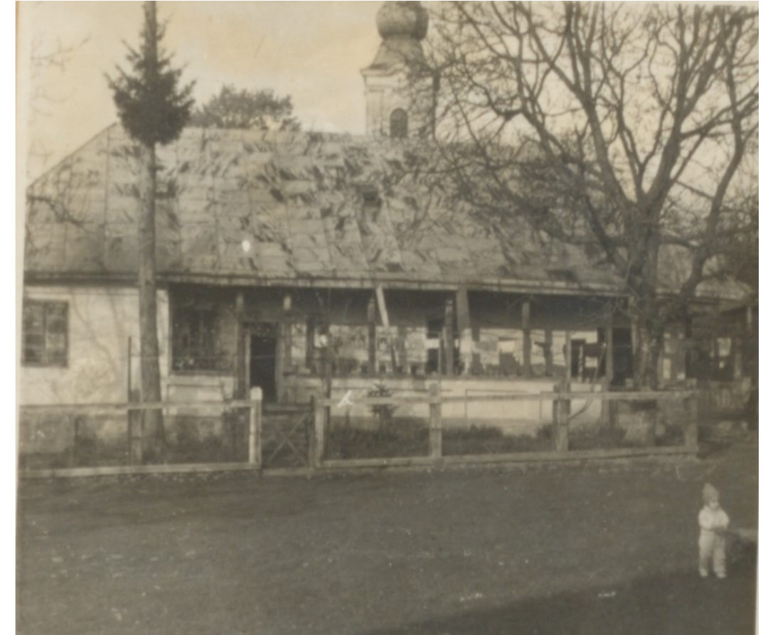
Casa parohială din Vama (1967)
