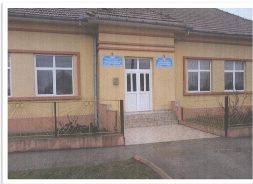
Școala Gimnazială Livada, clădirea nouă
