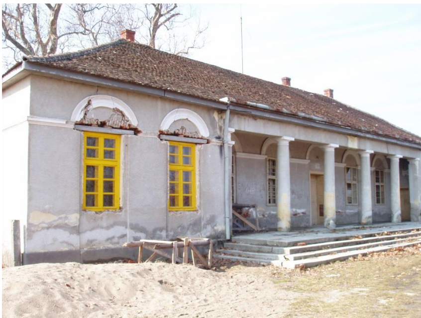
Conacul Ember Geza înainte de renovare
