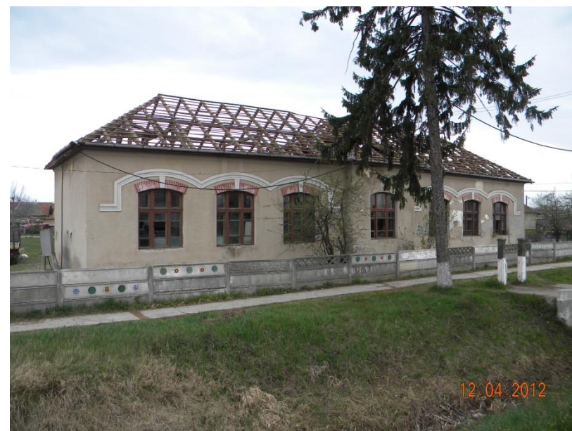
Grădinița Dorolț înainte de reabilitare
