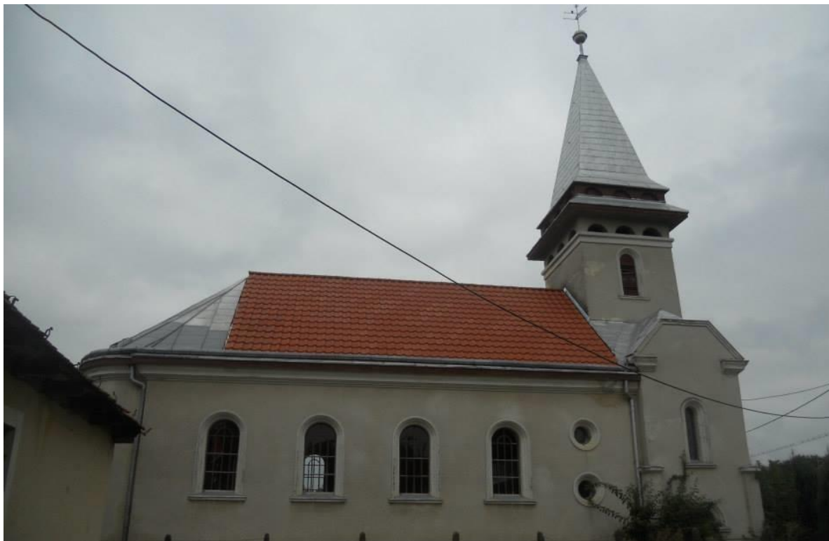
Biserica Reformată Dara înainte de renovare
