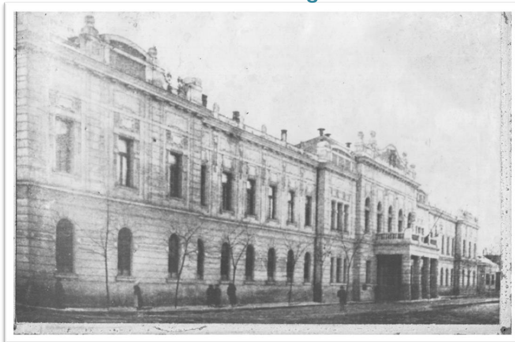
Fosta Prefectură-Azi Colegiul Tehnic
